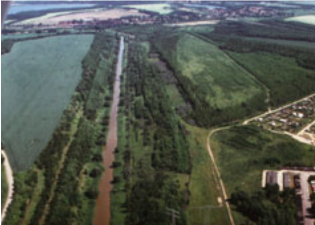
Abb. 3-3-4: Die Pleiße-Verlegung bei Neukieritzsch (Foto: BERKNER)
