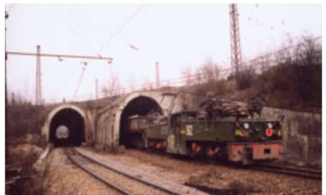
Abb. 5-6-13: Kreuzungsbauwerk Tagebau Zwenkau 1996 (Foto: NEDDERMEIER)
