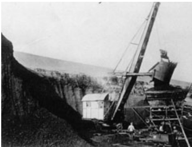
Abb. 5-2-8: Carlshütter Löffelbagger mit Beladetrichter für Kettenbahnunte (1917) (Foto: Archiv KAPPLER)
