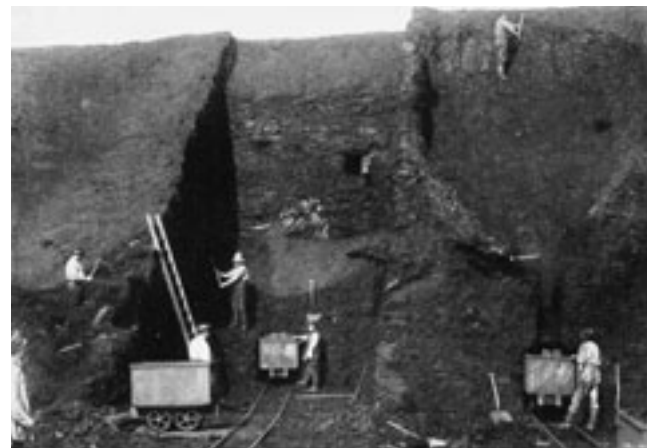
Abb. 4-5-3: Kohlegewinnung von Hand im Schlitzschurrenbetrieb (Foto: Archiv BRÄUTIGAM)
