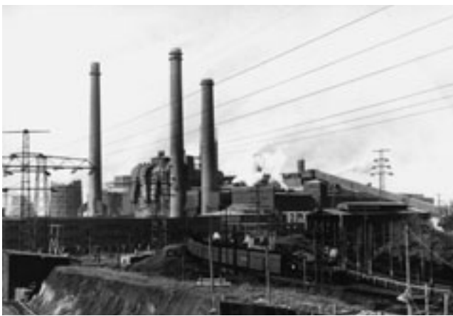
Abb. 5-4-6: Kraftwerk Böhlen – Außenansicht in den Fünfziger Jahren
