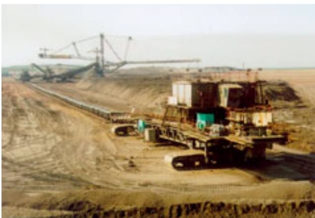
Abb. 5-2-49: Bandantriebsstation im Tagebau Espenhain
