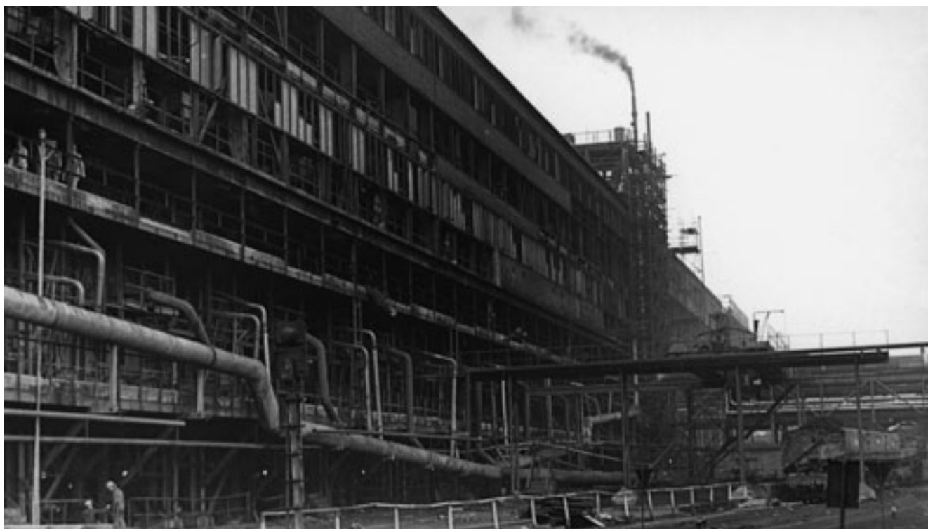
Abb. 5-5-6: Lurgi-Schwefelofenhaus (Gesamtansicht) (Foto: Archiv ZICHEL)
