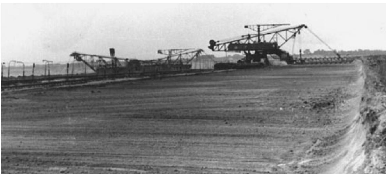
Abb. 5-2-19: Bagger 598 Es800, Einsatz von 1938 bis 1962 im Mittelabraum, danach bis 1994 im Vorschchnitt des Tagebaus Böhlen/Zwenkau (1993) (Foto: SCHUBERT)
