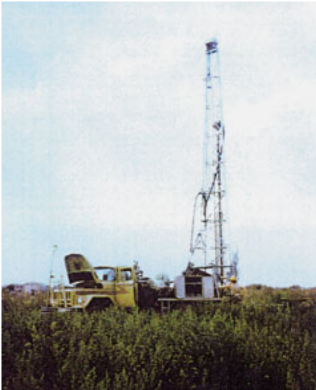
Abb. 2-2-2: Rotarybohrgerät bei Markkleeberg-Zöbiger im Tagebaubereich Cospuden
