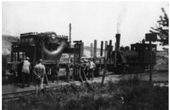
Abb. 5-4-5: Ausrüstungstransport beim Bau des Kraftwerkes Böhlen
