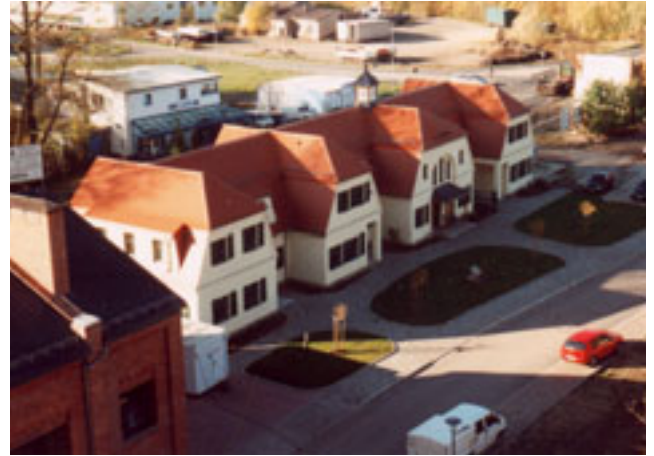
Abb. 6-2-5-3: Verwaltungsgebäude der Bleichertschen Kohlenwerke nach der Sanierung
