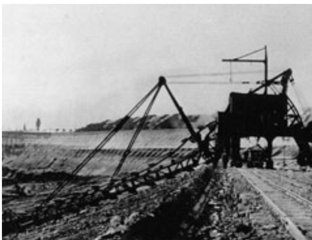
Abb. 5-2-10: Bagger E 300 Krupp im 3. Abraumschnitt im Tagebau Borna-Nord (1927) (Foto: Archiv KAPPLER)
