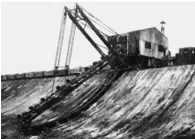
Abb. 4-5-4: Bagger älterer Bauart der Lübecker Maschinenbau-Gesellschaft (Foto: Archiv BRÄUTIGAM)
