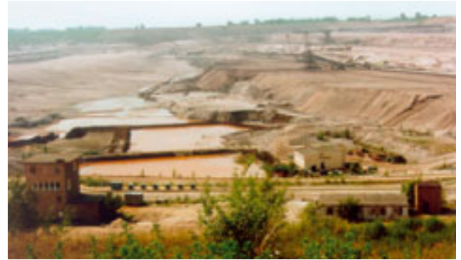
Abb. 5-2-53: Anstützung der setzungsfließgefährdeten Innenkippe im Tagebau Groitzscher Dreieck
