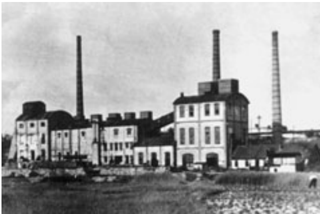
Abb. 4-6-2: Brikettfabrik „Germania“ bei Gorma (Foto: Archiv BRÄUTIGAM)
