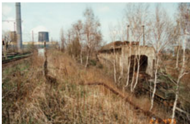
Abb. 5-6-15: Umladebunker Böhlen (Foto: KIRCHHÜBEL)
