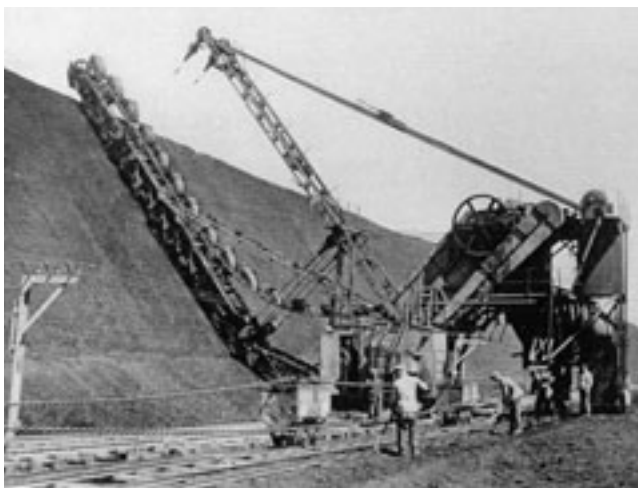
Abb. 5-2-9: LMG-Schrämbagger im Kohlehochschnitt (1917) (Foto: Archiv KAPPLER)
